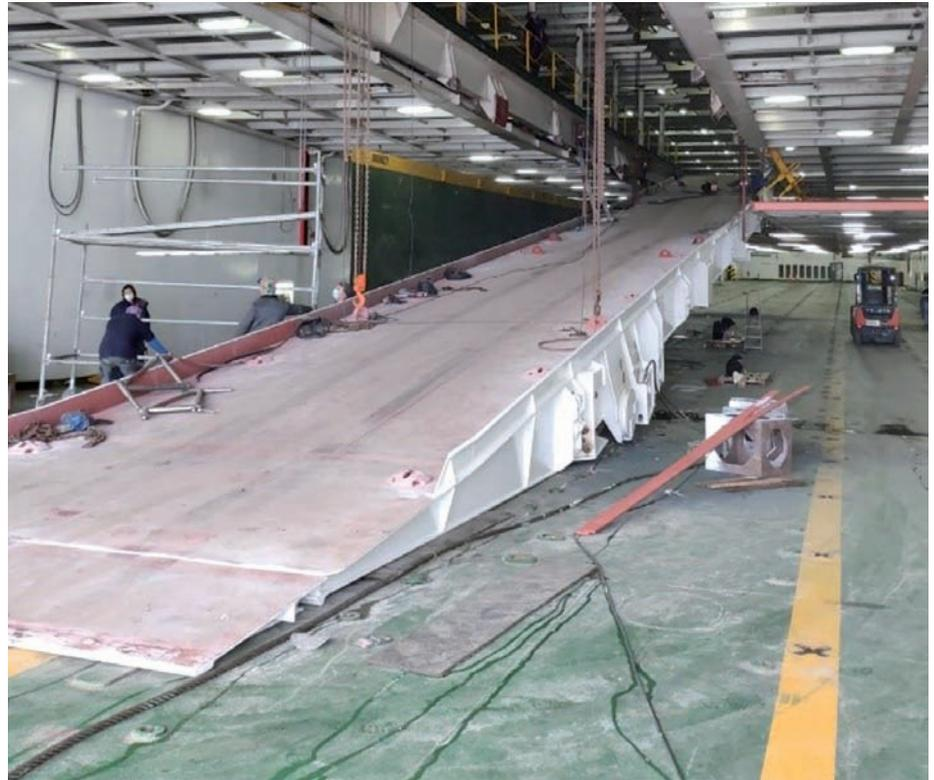
➤ Instalación de la nueva rampa suministrada por SP, con los sistemas hidráulicos y eléctricos de maniobra y control, entre Cubierta Principal y Cubierta Superior.
